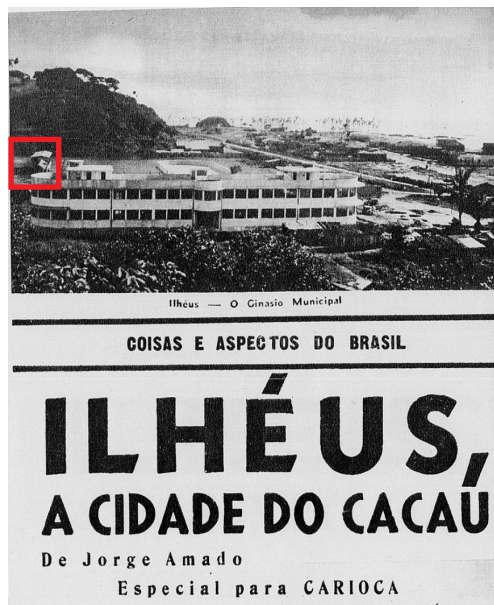
Figura 5 – Vista do Ginásio Municipal, onde pode-se notar a arquibancada em madeira do lado esquerdo atrás do prédio, do antigo Clube Satélite, que deu lugar ao estádio municipal. Fonte: Revista Carioca, Rio de Janeiro, n. 201, 19 ago. 1939, p. 4
